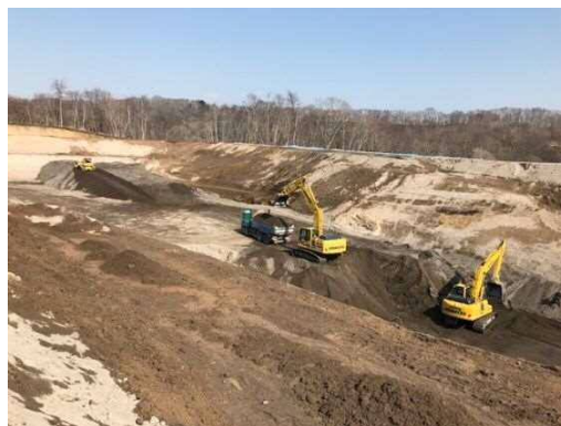
【管理型最終処分場建設地の現在の様子】
